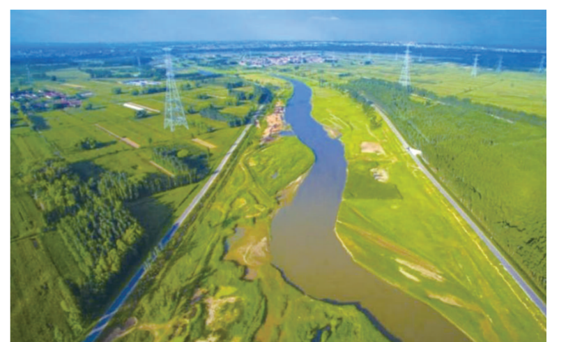
农发行山西省分行贷款支持的汾河百公里中游示范区项目
